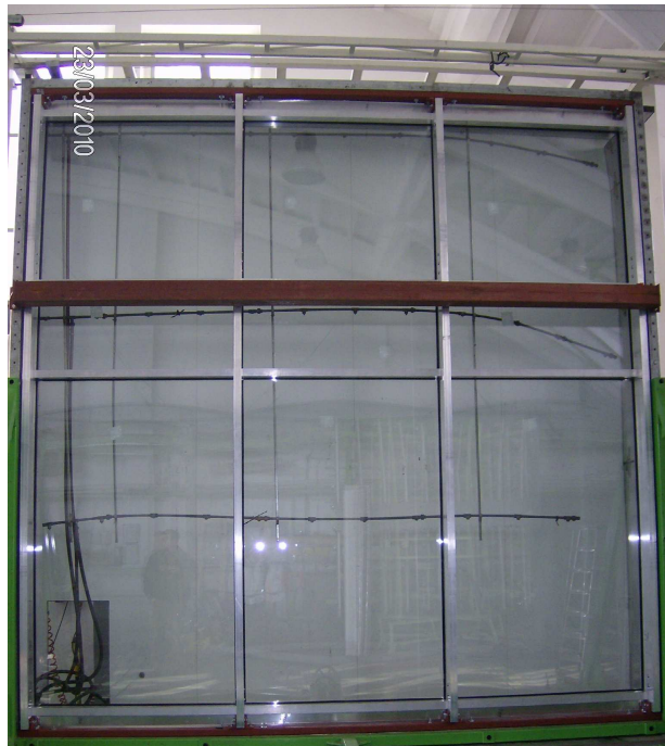
Fot.2. Ściana osłonowa MC WALL - widok od wewnątrz
